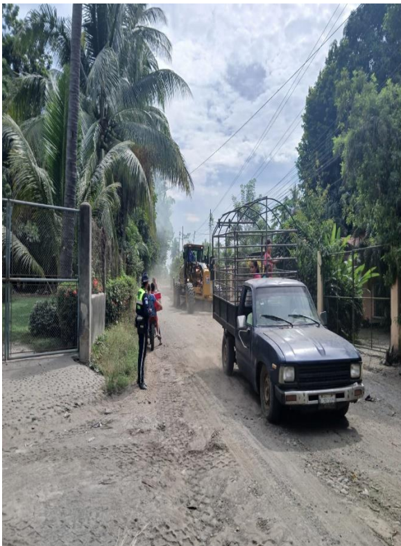
APOYO A MAQUINARIA
