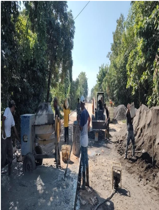
APOYO EN OBRA DE LAS PAMPAS
