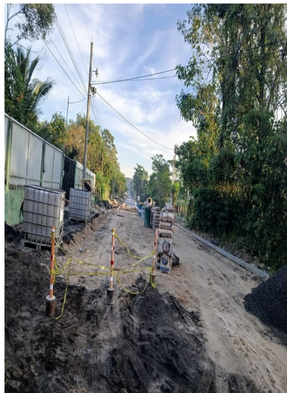
APOYO EN OBRA LAS PAMPAS
