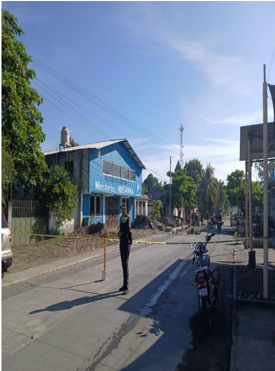
APOYO EN OBRA DE CALLE BELICE
