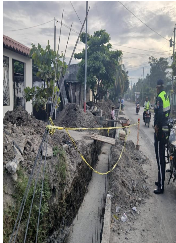
APOYO EN CALLE BELICE
