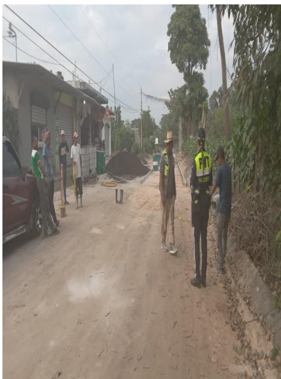
APOYO EN OBRA DE LAS PAMPAS
