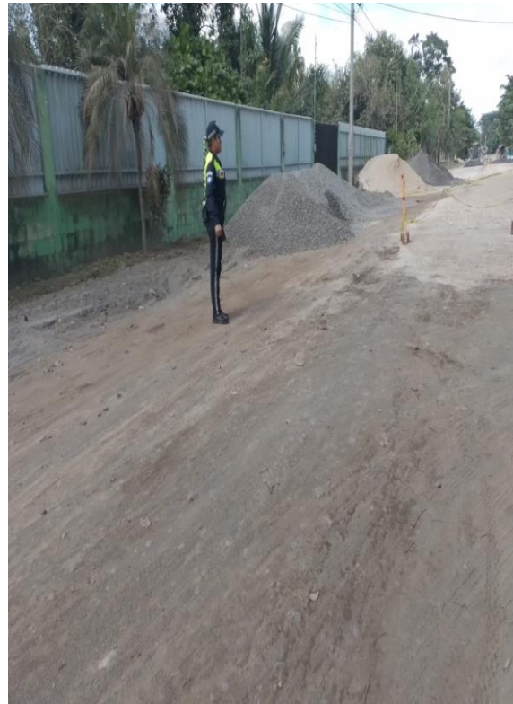
APOYO EN OBRA DE LAS PAMPAS
