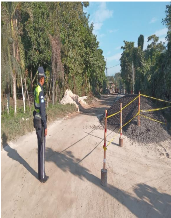
APOYO EN OBRA LAS PAMPAS
