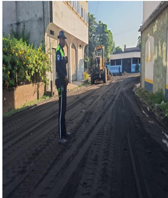
APOYO A MAQUINARIA
