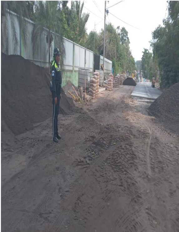
APOYO EN OBRA LAS PAMPAS
