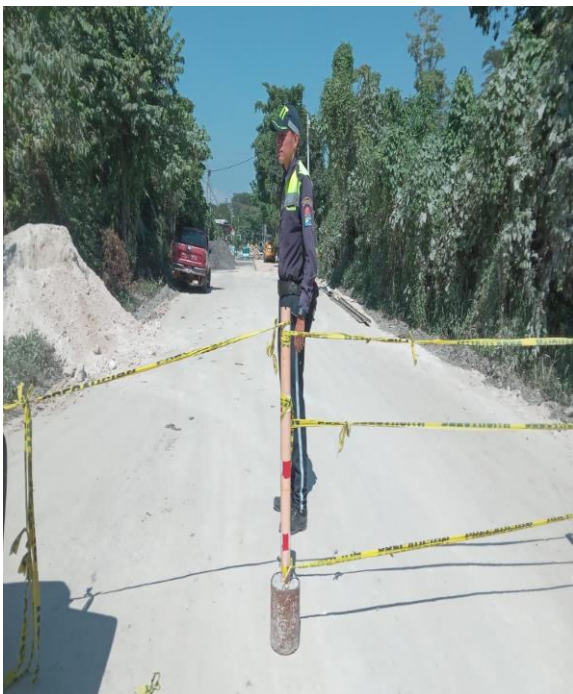
APOYO EN OBRA LAS PAMPAS
