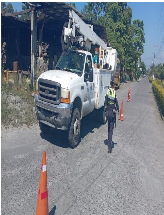
APOYO A ELECTRICISTAS MUNICIPALES
