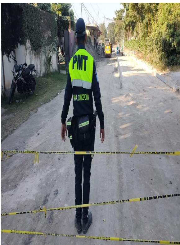
APOYO EN OBRA LAS PAMPAS
