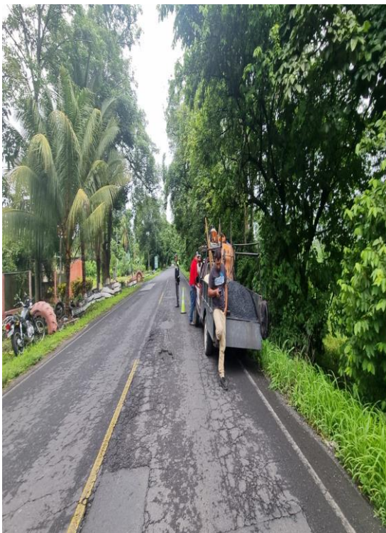
APOYO A BACHADORES
