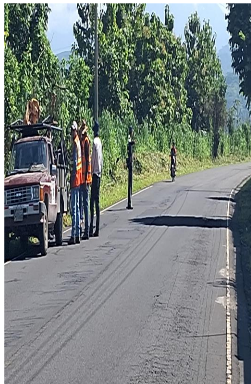
APOYO A BACHADORES
