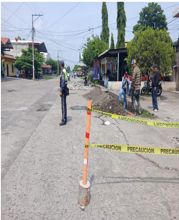
APOYO A ALBAÑILES
