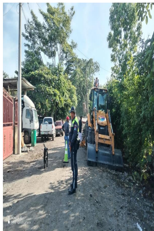
APOYO A MAQUINARIA
