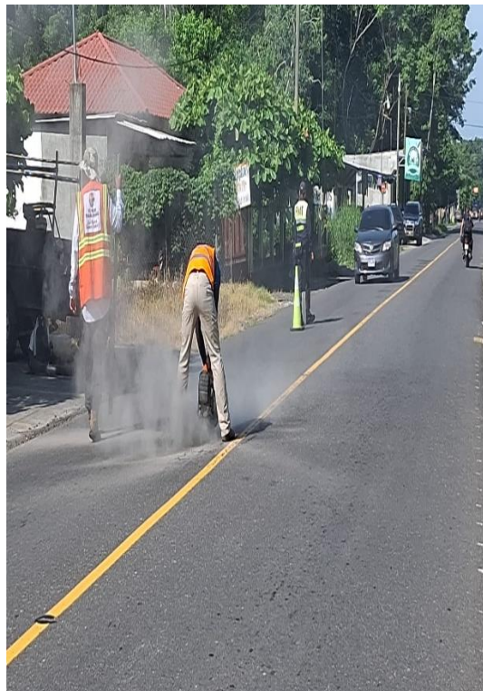
APOYO A BACHADORES
