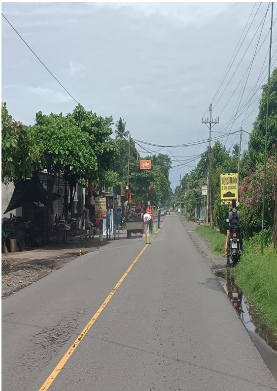
APOYO A BACHADORES
