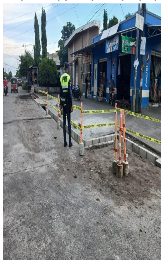
SEÑALIZACION EN CALLE HONDURAS
