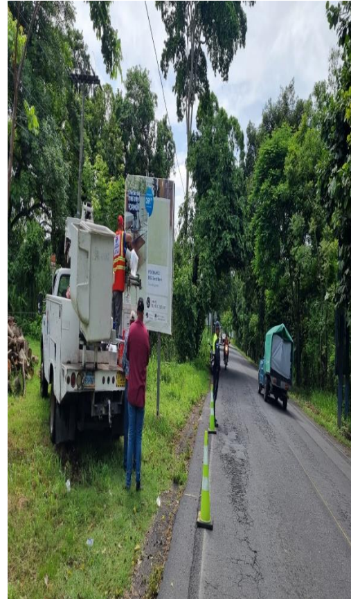
APOYO A ELECTRICISTAS MUNICIPALES
