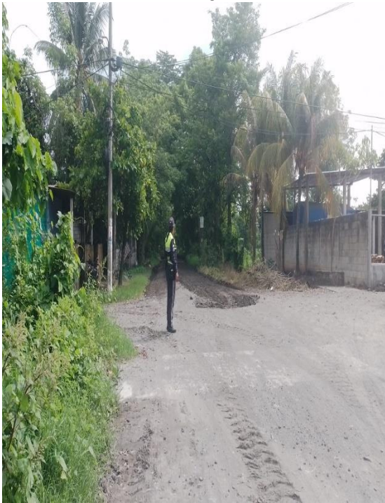
APOYO A MAQUINARIA
