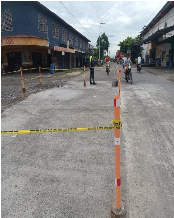
APOYO A ALBAÑILES
