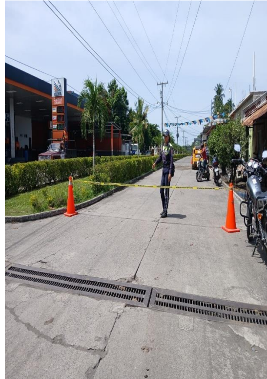
APOYO A MAQUINARIA
