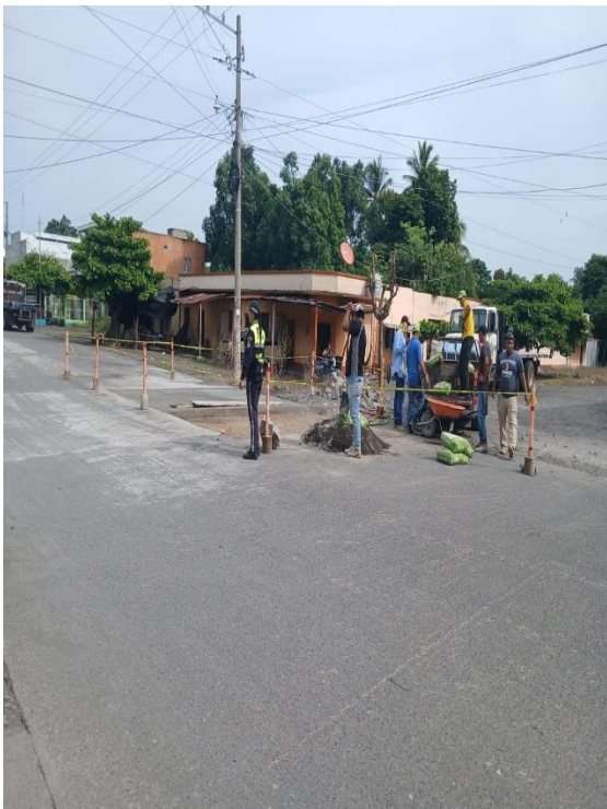
APOYO A ALBAÑILES
