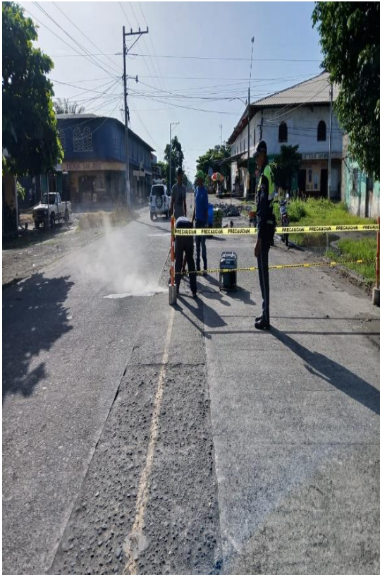
APOYO A ALBAÑILES
