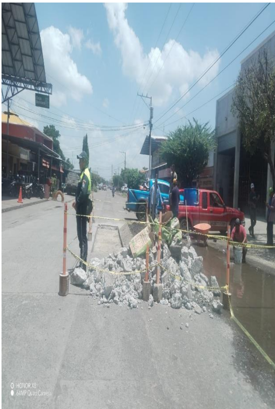
APOYO A ALBAÑILES
