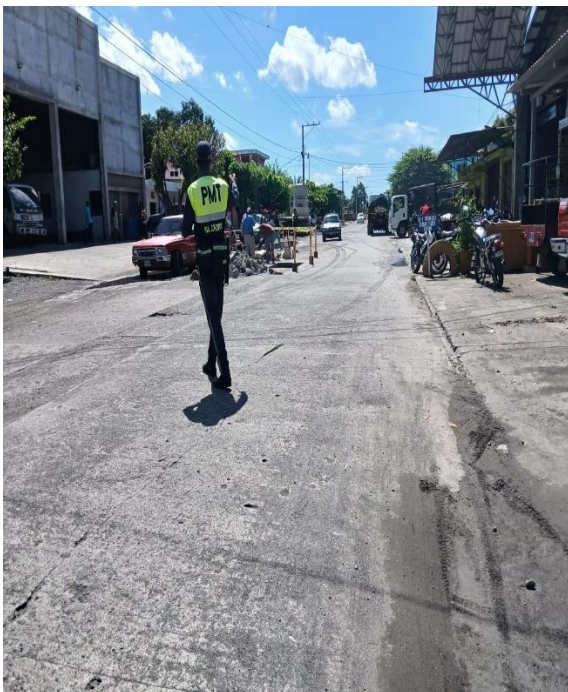
APOYO A ALBAÑILES
