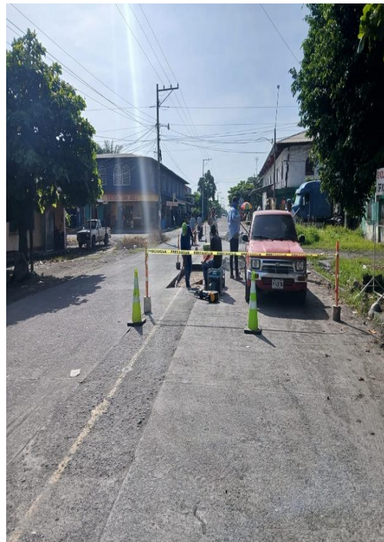
APOYO A ALBAÑILES
