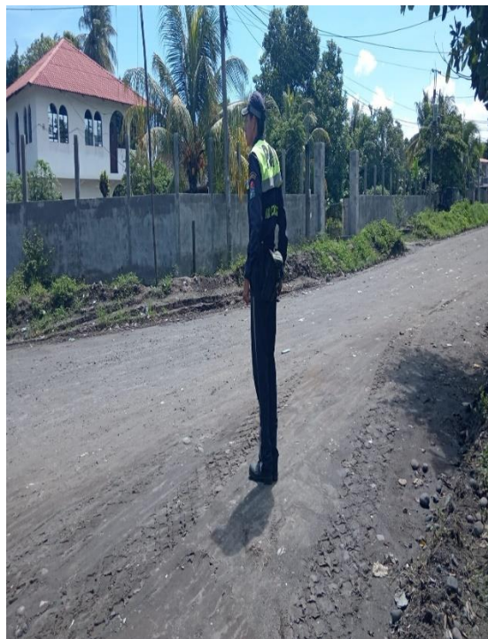
APOYO A MAQUINARIA
