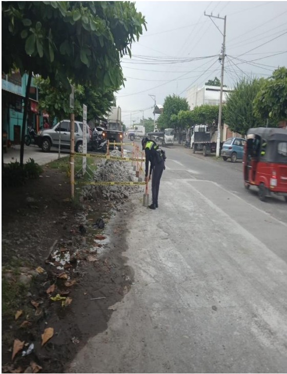
APOYO A ALBAÑILES
