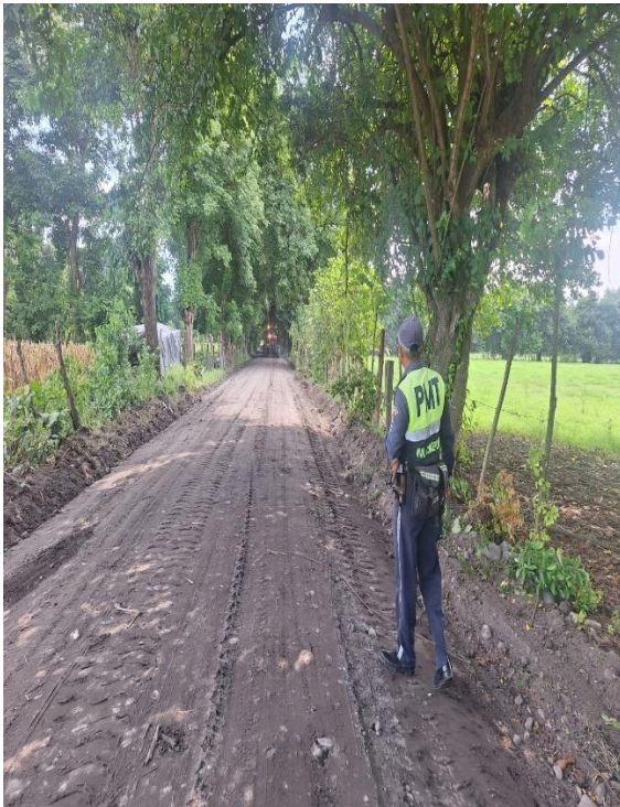
APOYO A MAQUINARIA
