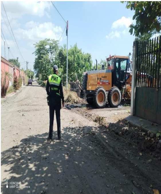
APOYO A MAQUINARIA
