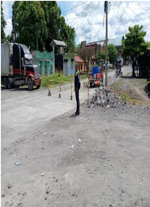
APOYO A ALBAÑILES
