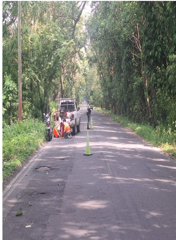
APOYO A ALBAÑILES
