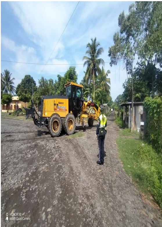
APOYO A MAQUINARIA
