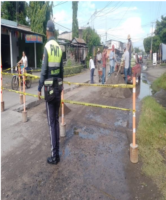
APOYO A ALBAÑILES
