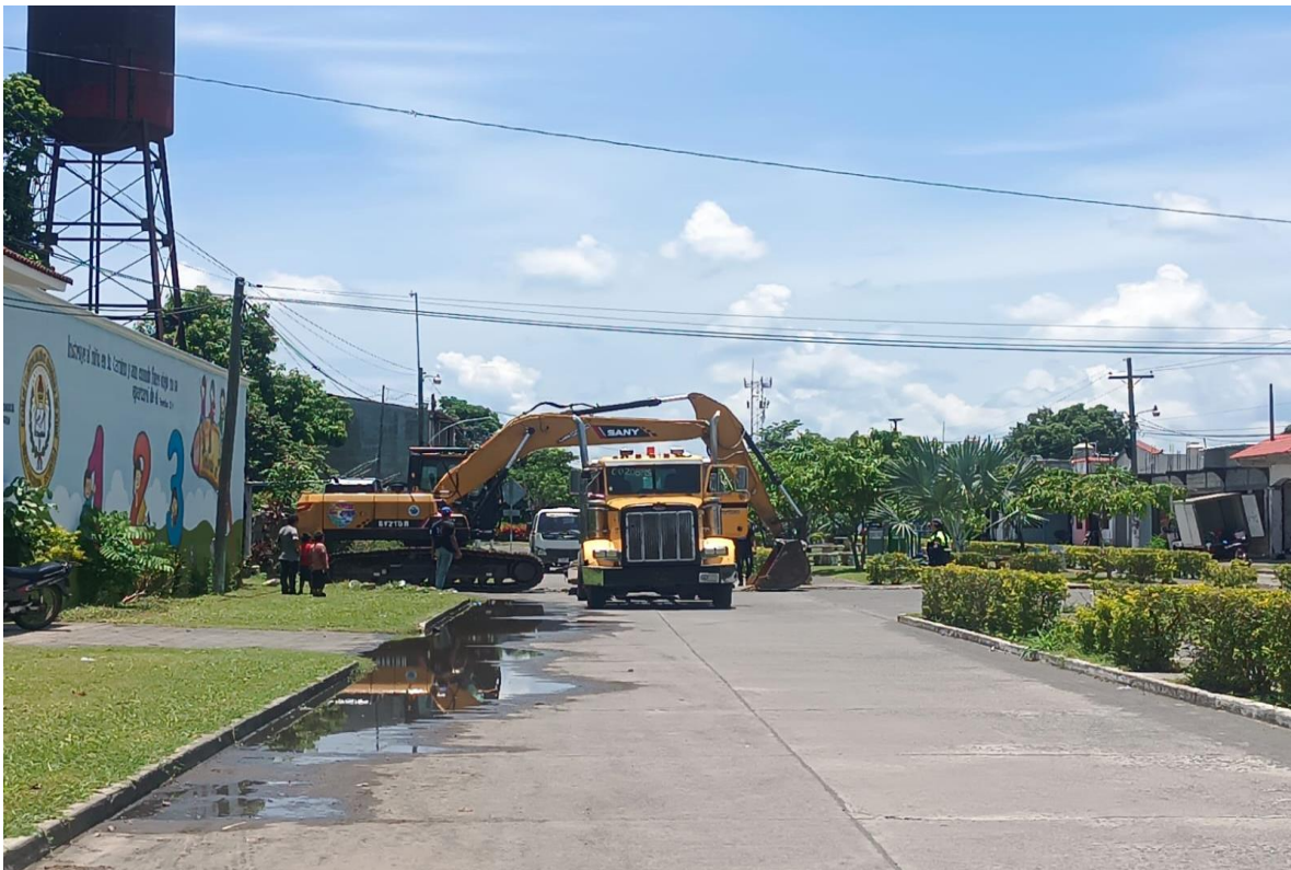
APOYO A MAQUINARIA
