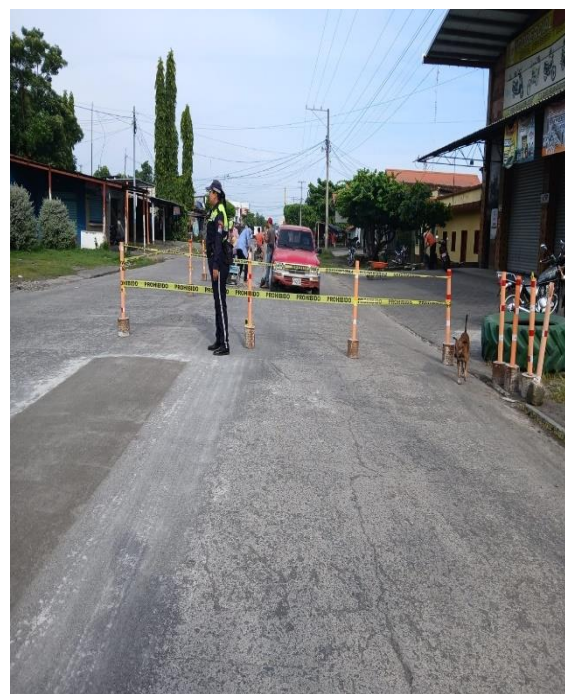
APOYO A ALBAÑILES
