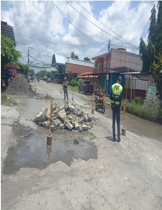
APOYO A ALBAÑILES
