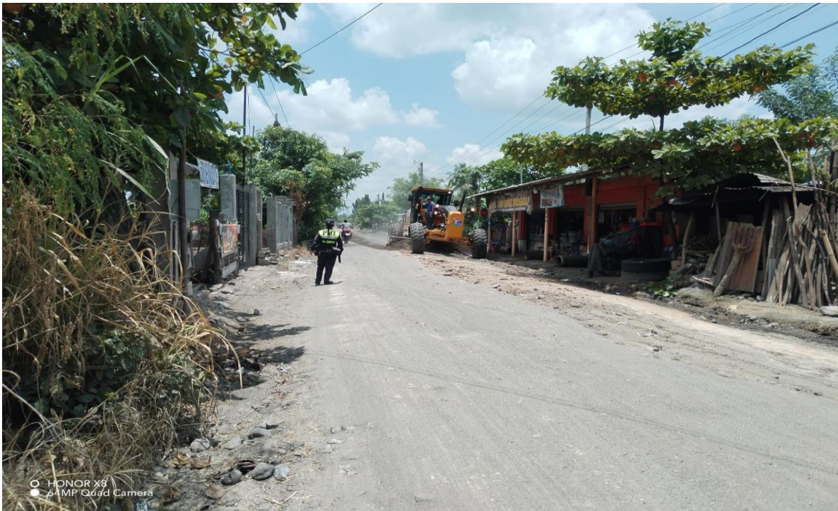
APOYO A MAQUINARIA
