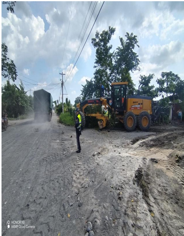
APOYO A MAQUINARIA
