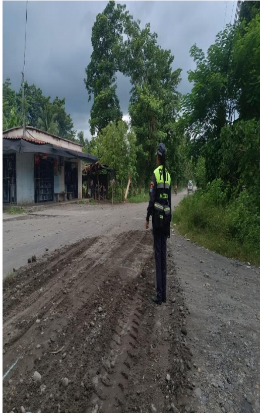
APOYO A MAQUINARIA
