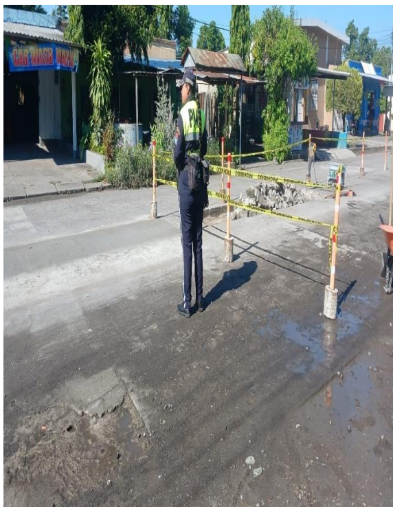
APOYO A ALBAÑILES
