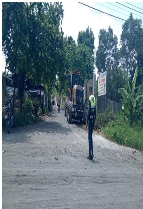
APOYO A MAQUINARIA
