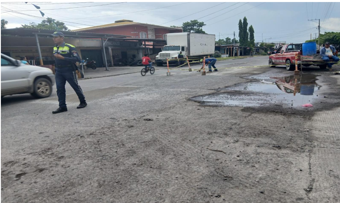
APOYO A ALBAÑILES
