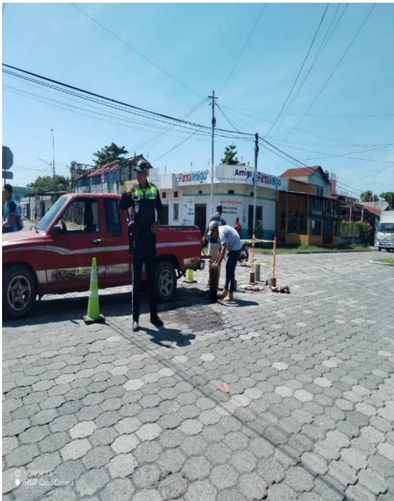
APOYO A ALBAÑILES
