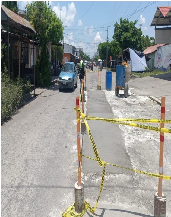
APOYO A ALBAÑILES
