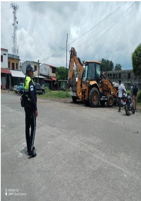
APOYO A MAQUINARIA
