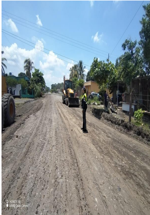
APOYO A MAQUINARIA
