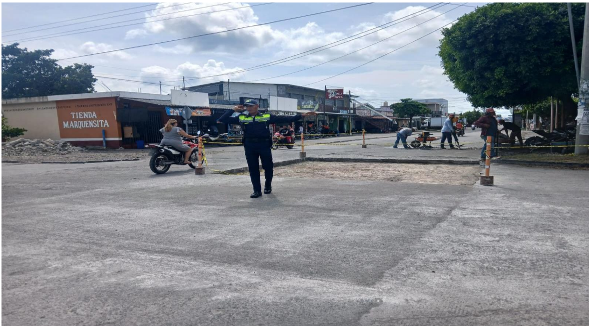
APOYO A ALBAÑILES EN AVENIDA PONDEROSA
