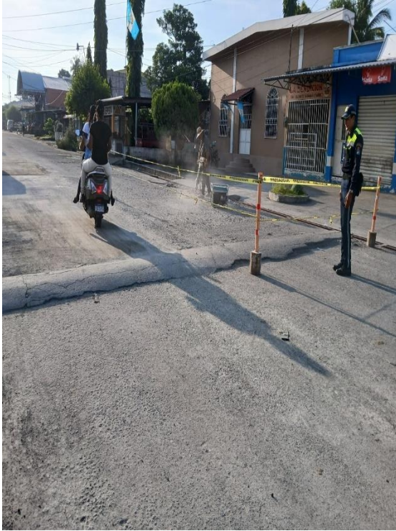
APOYO A ALBAÑILES EN CALLE HONDURAS
