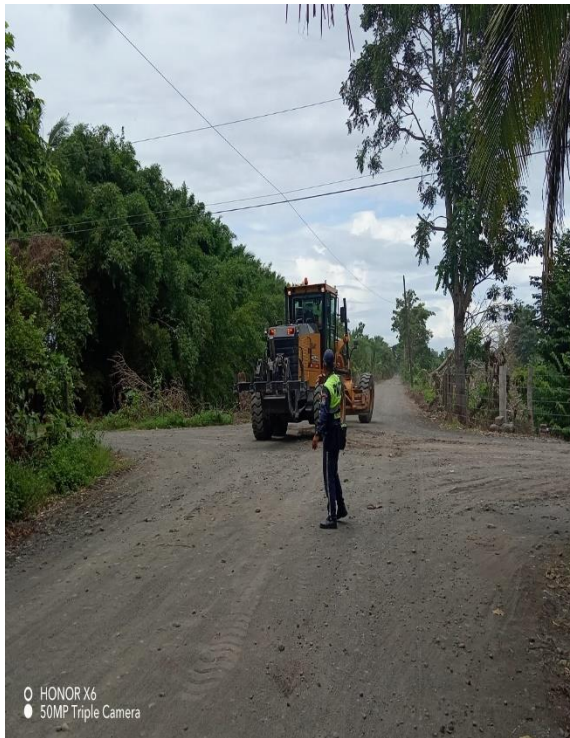
APOYO A MAQUINARIA
