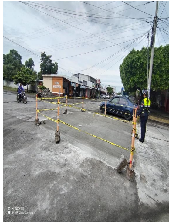
APOYO A ALBAÑILES EN CALLE HONDURAS
