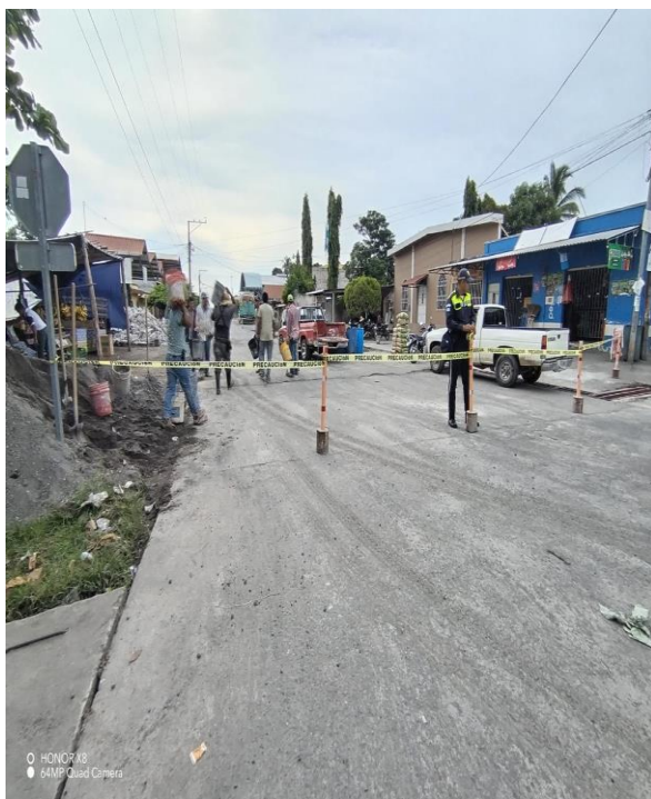
APOYO A ALBAÑILES EN CALLE HONDURAS
