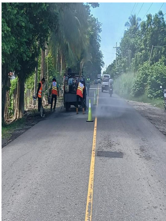
APOYO A BACHADORES
