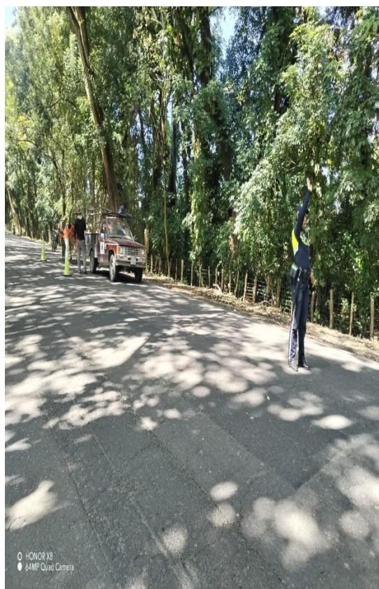
APOYO A BACHADORES
