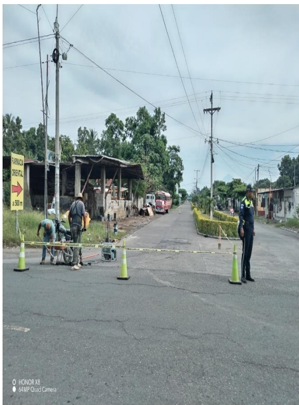
APOYO A ALBAÑILES EN CALLE PANAMA
