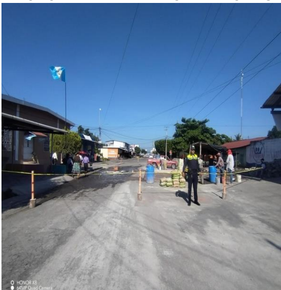
APOYO A LBAÑILES EN CALLE HONDURAS
