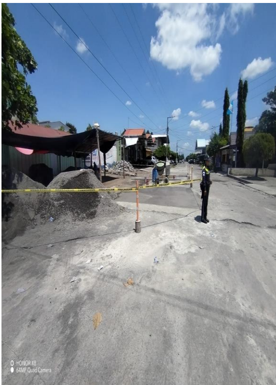
APOYO A ALBAÑILES EN CALLE HONDURAS
