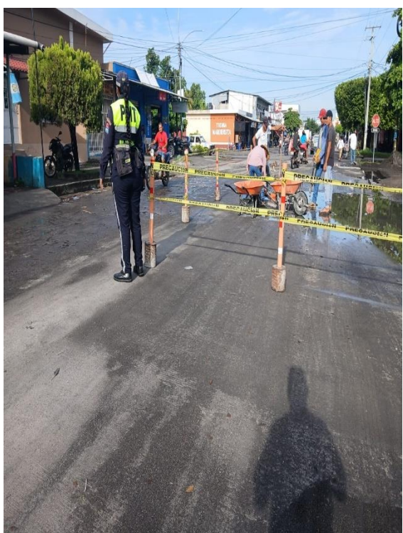
APOYO A ALBAÑILES EN CALLE HONDURAS
