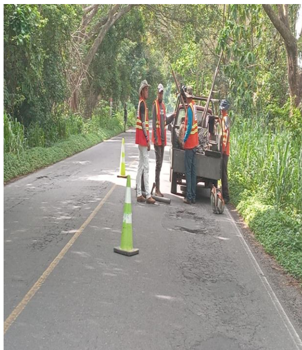
APOYO A BACHADORES
