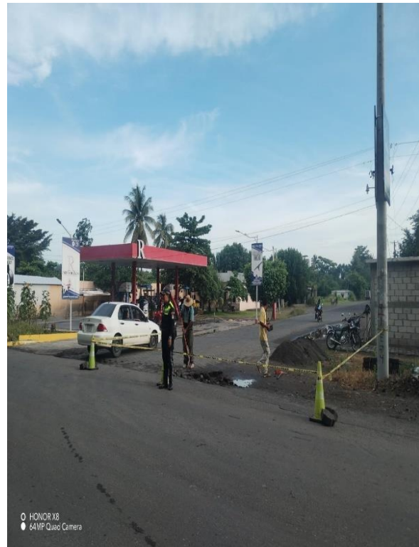
APOYO A ALBAÑILES EN CALLE PANAMA
