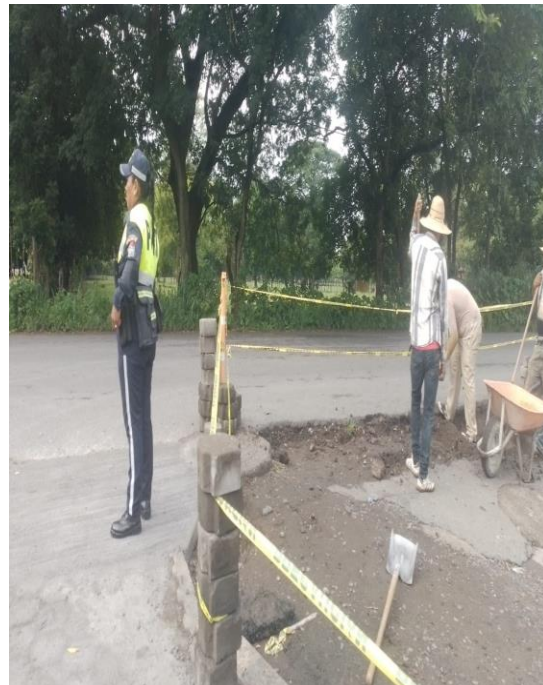
APOYO A ALBAÑILES EN CALLE PANAMA
