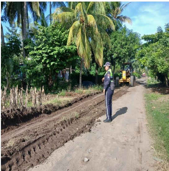
APOYO A MAQUINARIA
