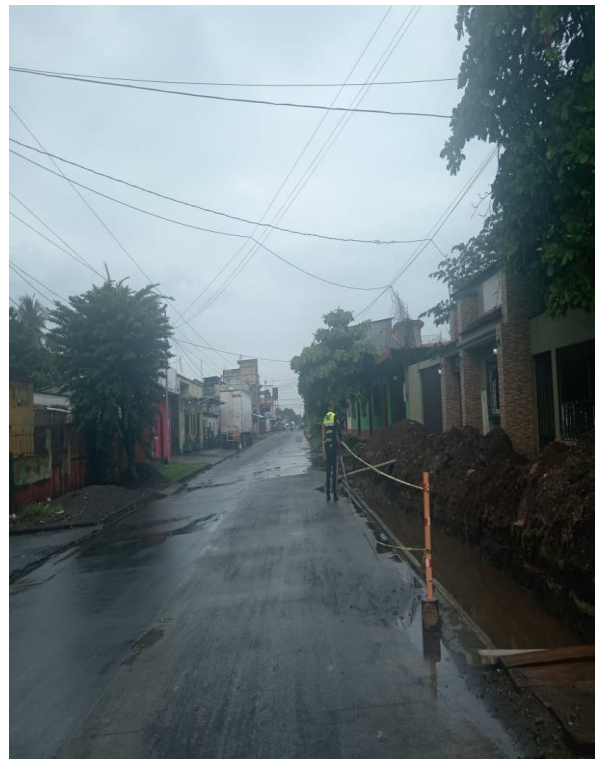
APOYO A ALBAÑILES
