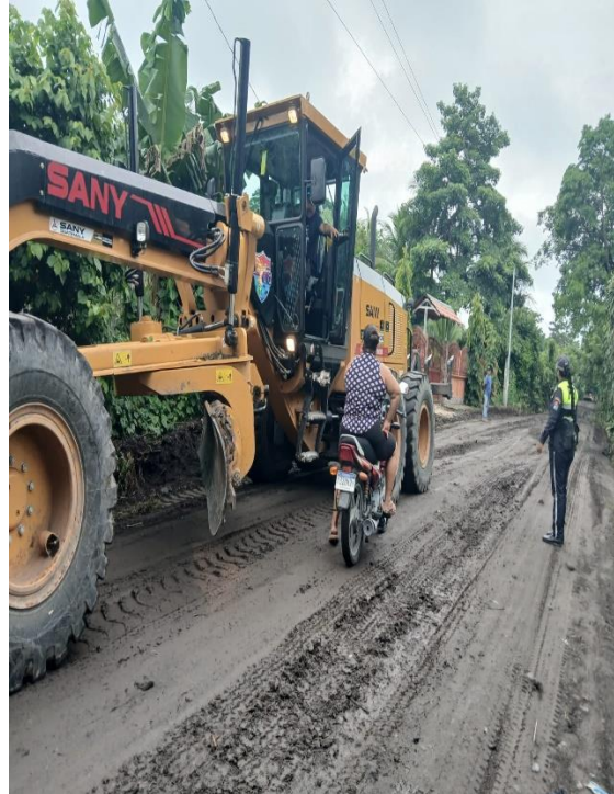
APOYO A MAQUINARIA
