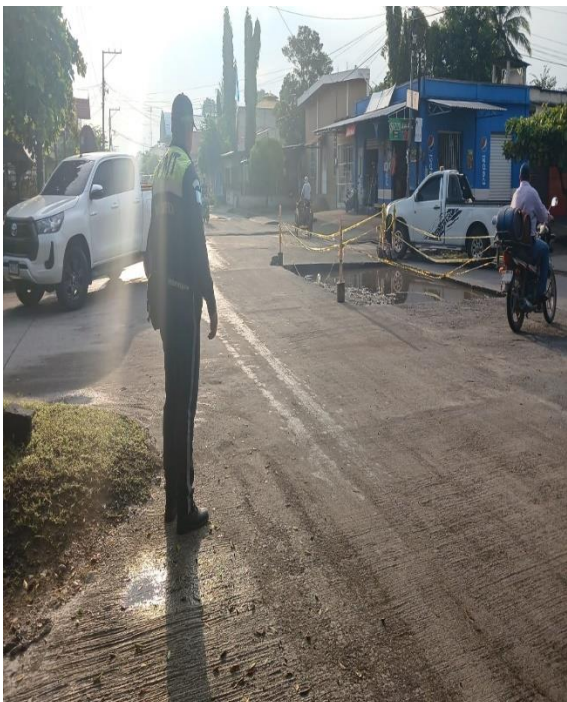
APOYO A ALBAÑILES
