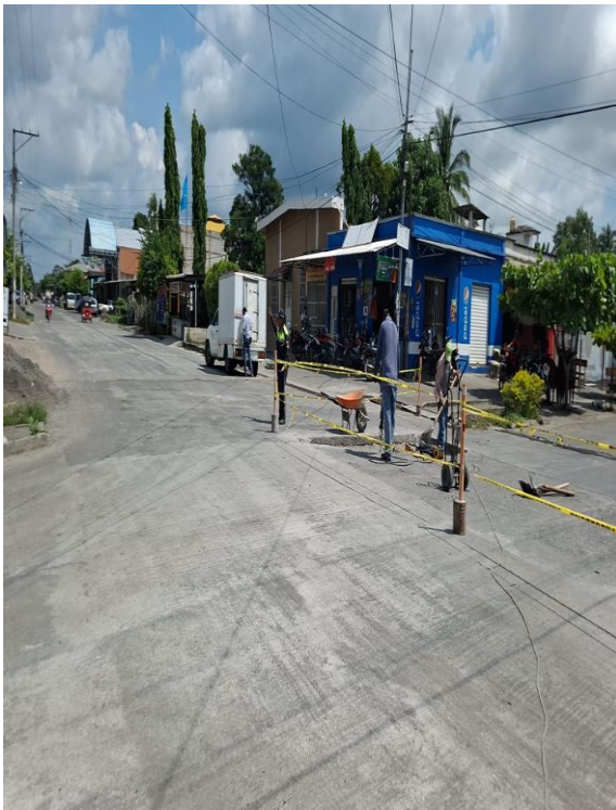
APOYO A ALBAÑILES
