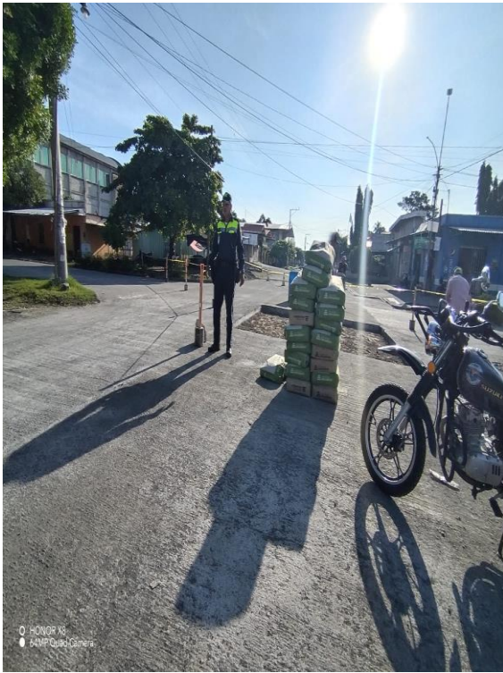
APOYO A ALBAÑILES
