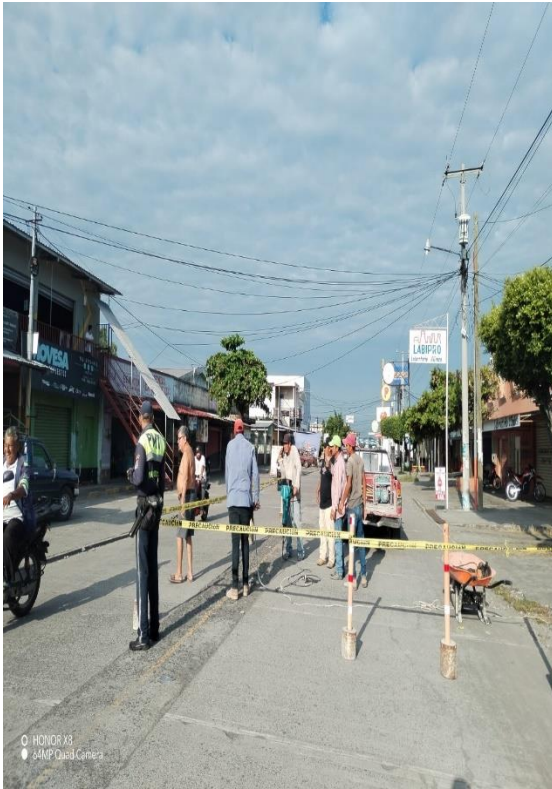
APOYO A ALBAÑILES
