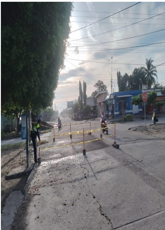
APOYO A ALBAÑILES MUNICIPALES
