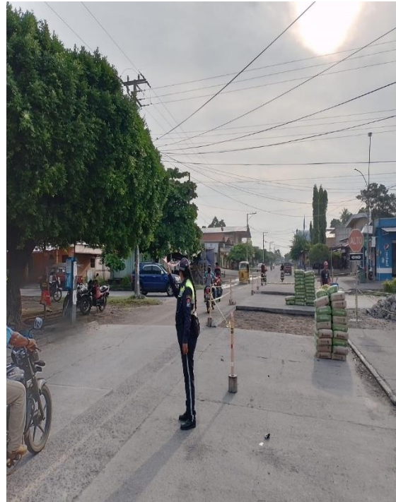
APOYO A ALBAÑILES
