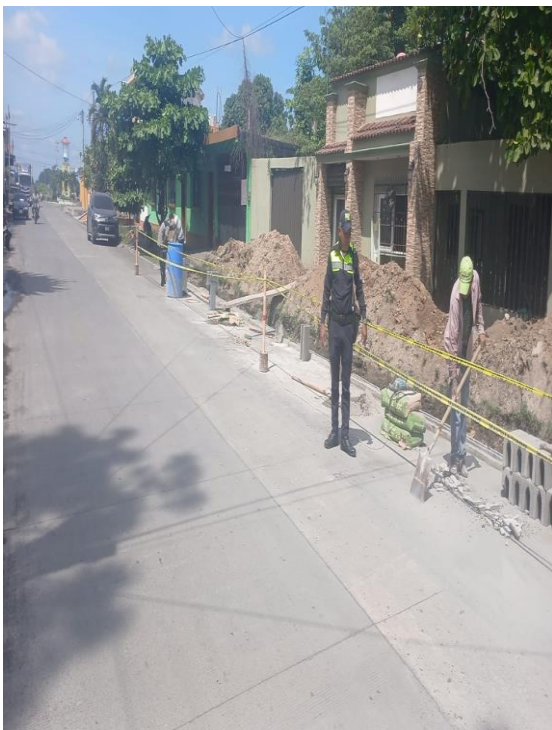
APOYO A ALBAÑILES EN CALLE BELICE
