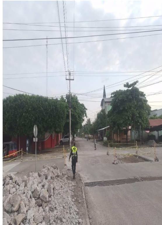
APOYO A ALBAÑILES
