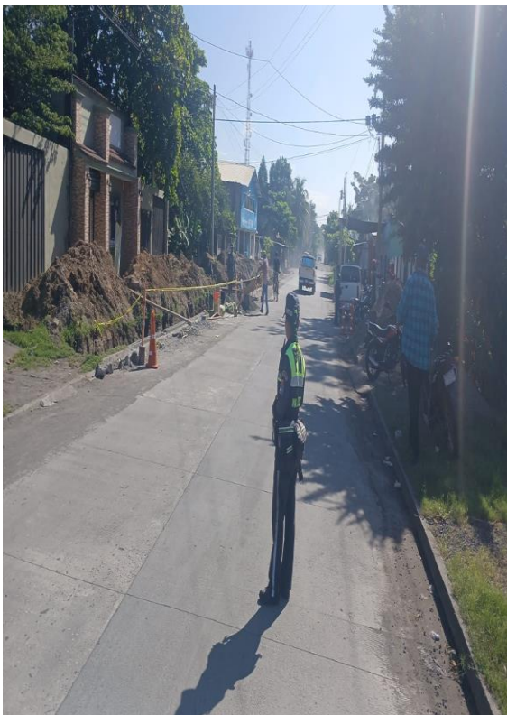
APOYO A ALBAÑILES EN CALE BELICE
