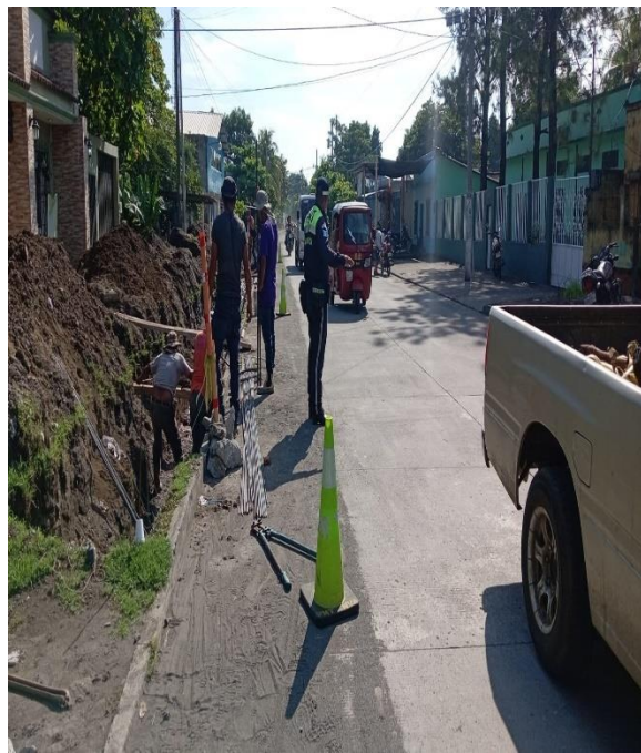
APOYO A ALBAÑILES MUNICIPALES
