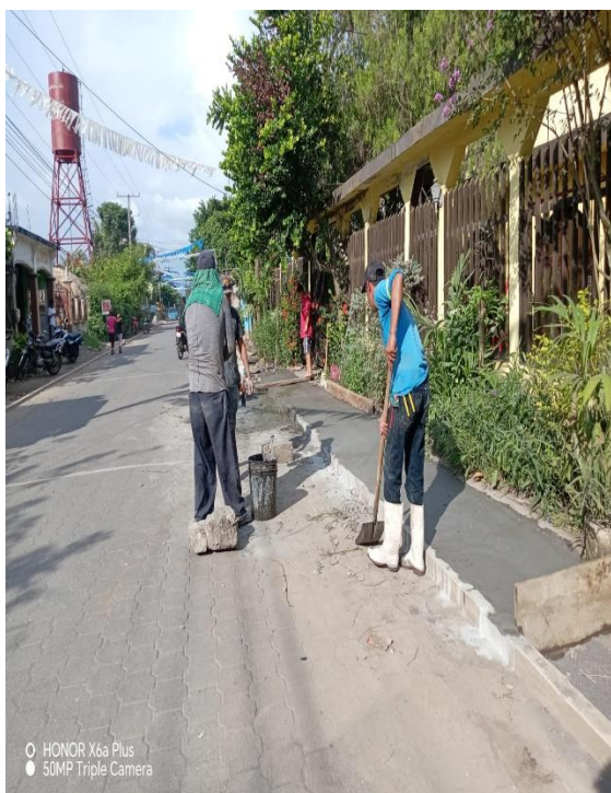
APOYO A ALBAÑILES MUNICIPALES
