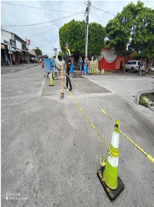
APOYO A ALBAÑILES MUNICIPALES
