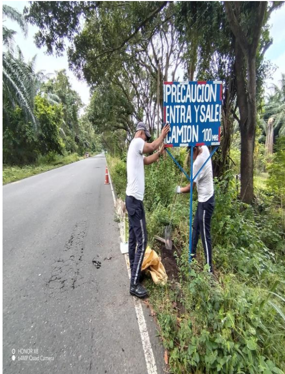
COLOCACION DE ROTULO
