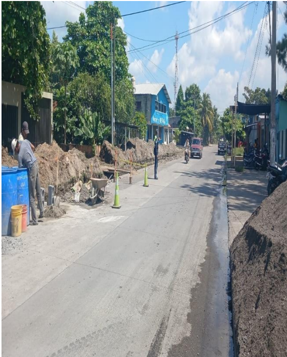
APOYO A ALBAÑILES MUNICIPALES
