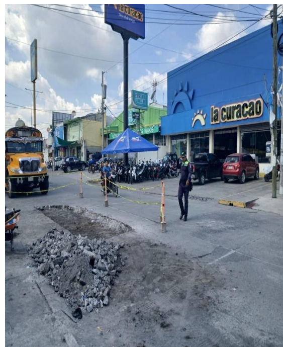
APOYO A ALBAÑILES MUNICIPALES
