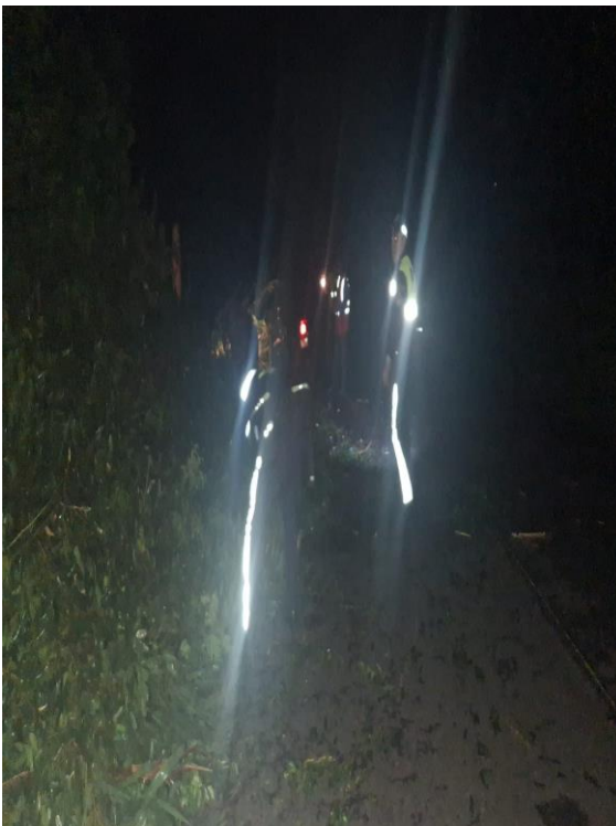
APOYO A LIBERACION DE VIA
