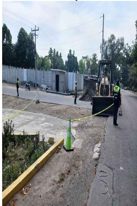
APOYO A MAQUINARIA
