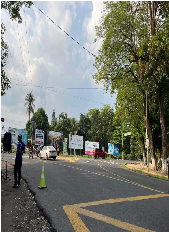
APOYO EN CRUCE TECOJATE
