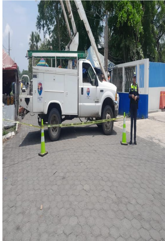
APOYO A ELECTRICISTAS MUNICIPALES
