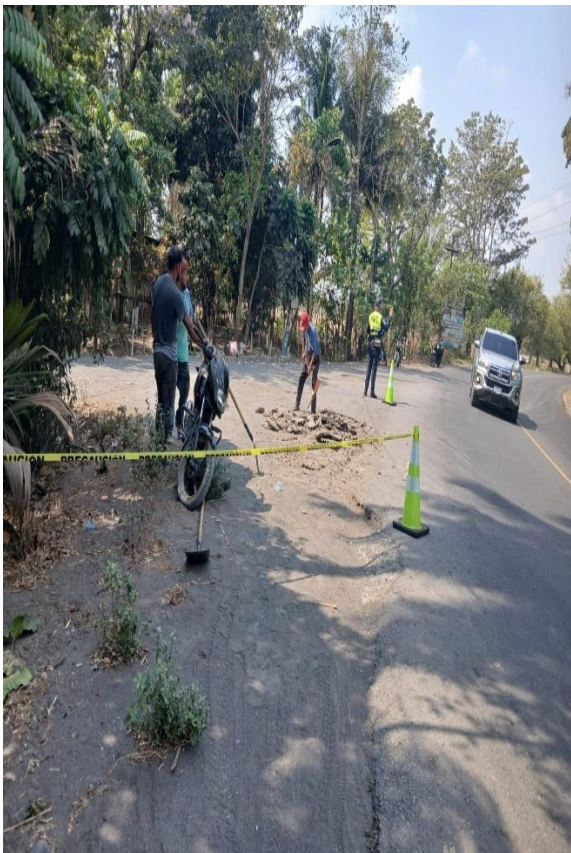
APOYO A ALBAÑILES EN VUELTA COSTA SUR
