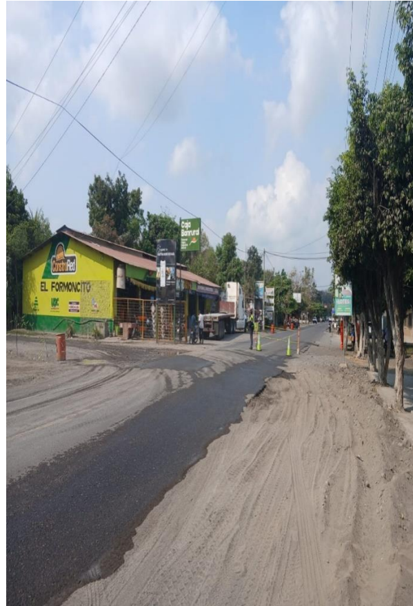
APOYO EN ALDEA CENTRO DOS
