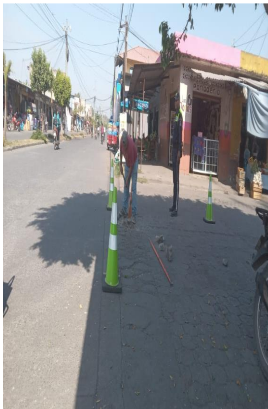
APOYO A ALBAÑILES
