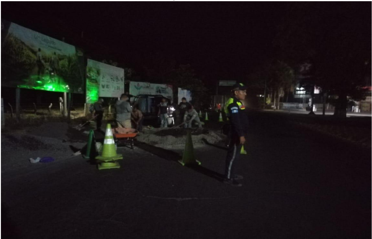
APOYO EN CRUCE TECOJATE, COLOCACIÓN DE CEMAFOROS
