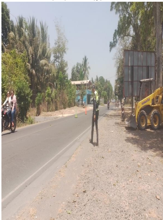
APOYO A MAQUINARIA
