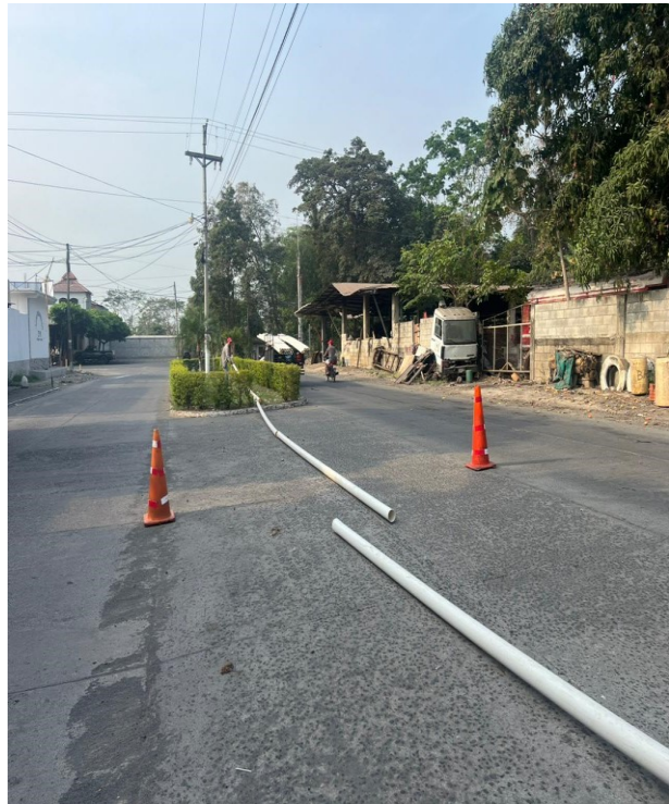
APOYO A RIEGO EN AV. ANTONIO YANES
