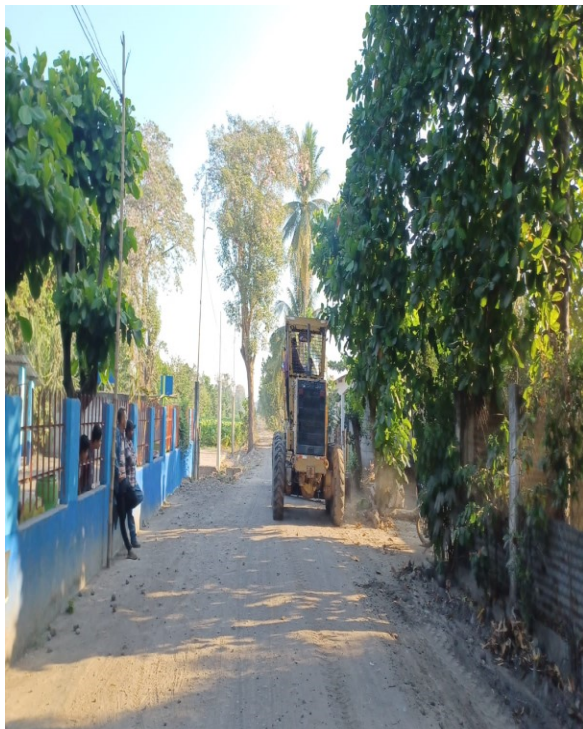
APOYO A MAQUINARIA
