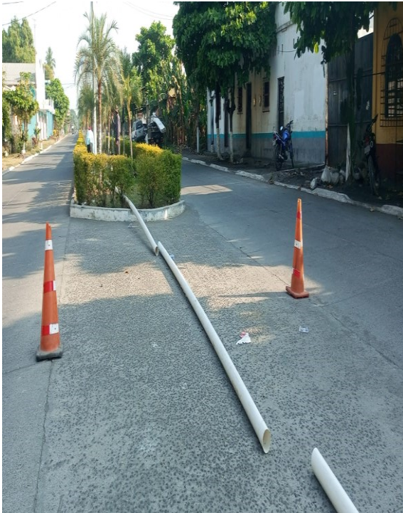
APOYO A RIEGO EN AV. ANTONIO YANES
