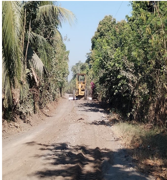
APOYO A MAQUINARIA EN TROCHA 5 CALLE 10
