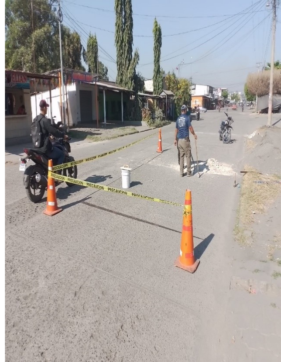
APOYO A ALBAÑILES EN CALLE CENTRAL
