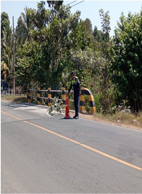
APOYO A REPARACIÓN PUENTE CENTRO DOS
